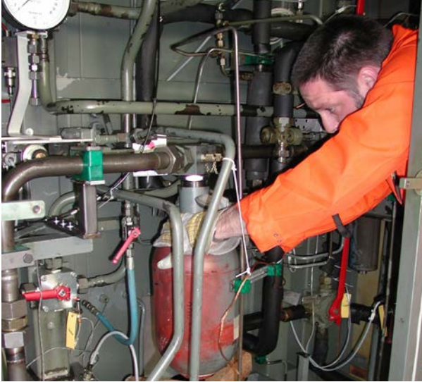
Abb. 1 Instandhalter bei Wartungsarbeiten
