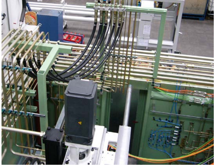
Abb. 11 Rohrverlegung an einer Großmaschine
